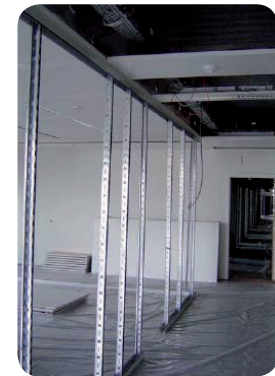
Fig. 1 - Ossature d'une cloison démontable.
