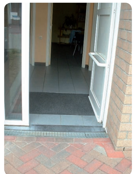
Exemple de seuil contribuant directement à l'étanchéité à l'eau et à l'air de l'ensemble menuisé associé à une ouverture télécommandée.
