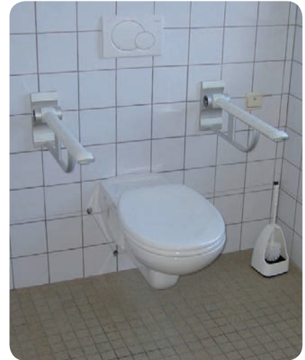
Placement de barres d'appui dans W.-C. adapté.
